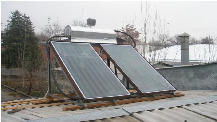
Расми дастгоҳи обгармкунии офтобии дудавра (дуконтур)
